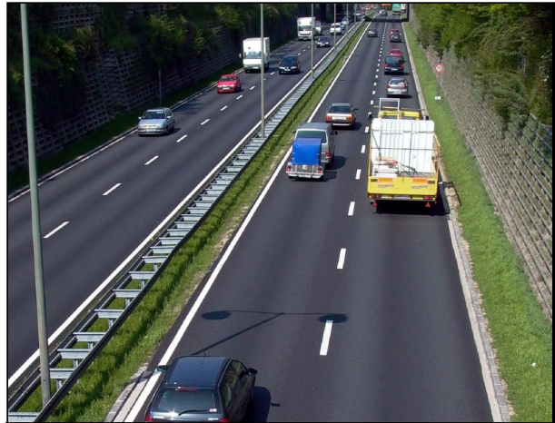
B 17 in Augsburg. Zweilagige offenporige Asphaltdeckschicht. Quelle: LUBW, Foto: Ulrich Ratzel.
