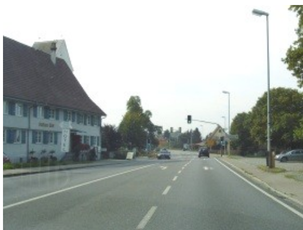
Gebäude an der überdimensionierten Ortsdurchfahrt fallen, wie hier rechts, kaum auf. Die Breite verführt zum Rasen.
