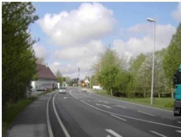
Die B 30 ist in Gaisbeuren viel zu breit ausgebaut (Foto: OV Gaisbeuren)
