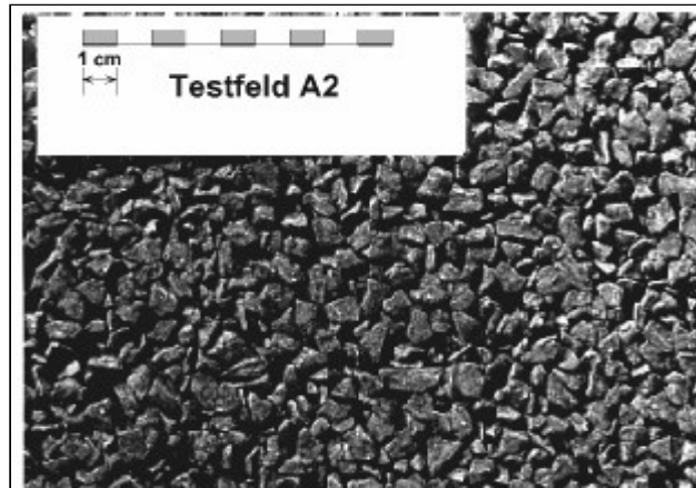
Oberfläche eines zweilagigen offenporigen Asphalts, Decklage 4/8. Quelle: LUBW - Lärmarme Reifen und geräuschkindernde Fahrbahnbeläge
